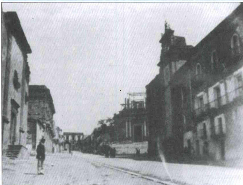
Nella foto: lavori di costruzione del nuovo prospetto della chiesa del Carmine (1910 c.ca).
