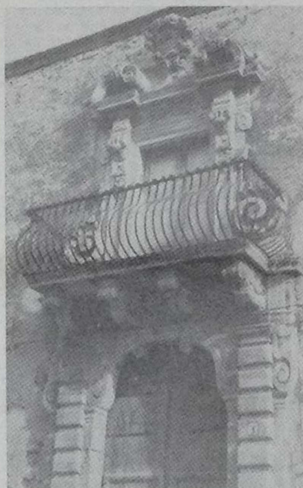
Palazzo Truncali-Panitteri-Amodei: balcone centrale, particolare.
